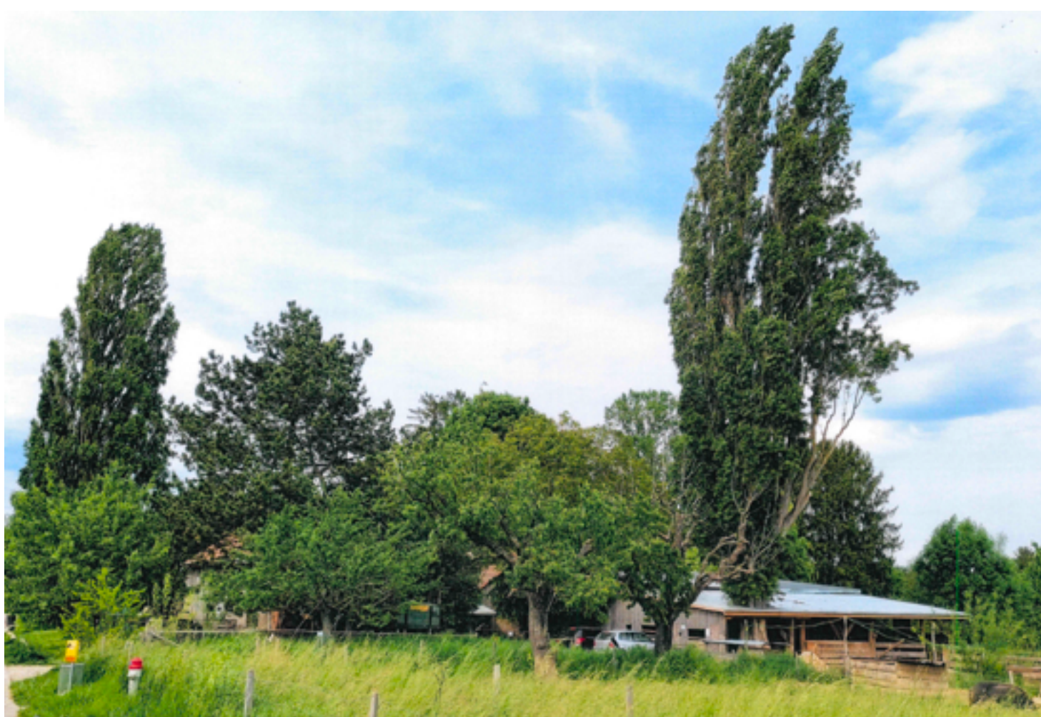
Auf dem nach Süden gerichteten Dach des neuen Stallgebäudes soll die Solaranlage entstehen. Die alte Pappel steht mittlerweile nicht mehr.
